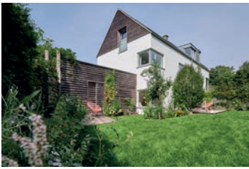
EFH Sanierung 1.jpg
