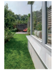
EFH Sanierung 4.jpg
