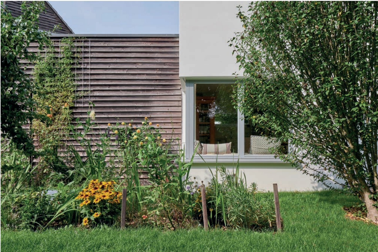
EFH Sanierung 2.jpg
