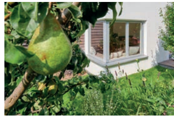
EFH Sanierung 3.jpg
