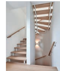
EFH Sanierung 15.jpg
