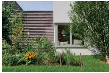
EFH Sanierung 2.jpg
